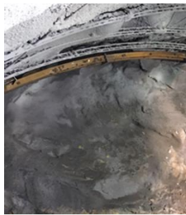
Figura 104 – Colocação de cambota (Fonte: Consórcio)
