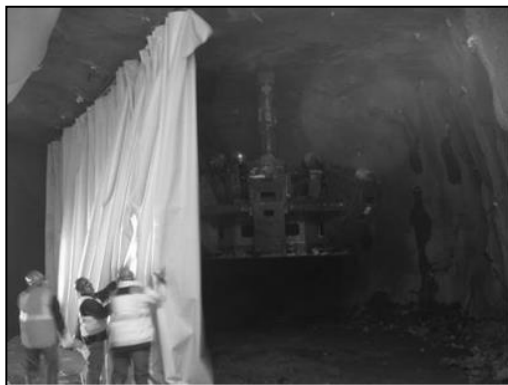
Figura 16- Sistema de contenção de poeiras “Cortinas”
