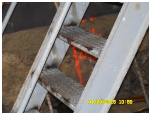
Figura 12 - Piso antiderrapante em escadas de acesso
