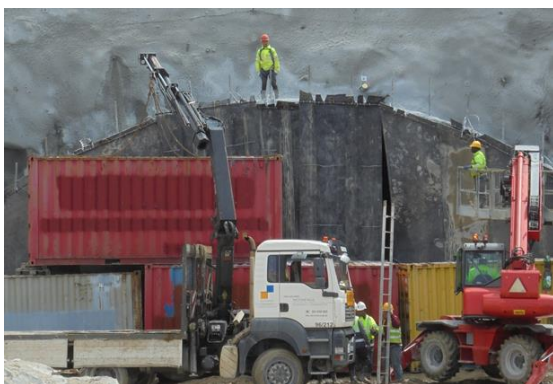
Figura 8 - Utilização de sistema anti-queda do tipo retrátil (JRG e arnês de segurança) para auxílio na colocação das telas de proteção do túnel (Fonte: Consórcio)
