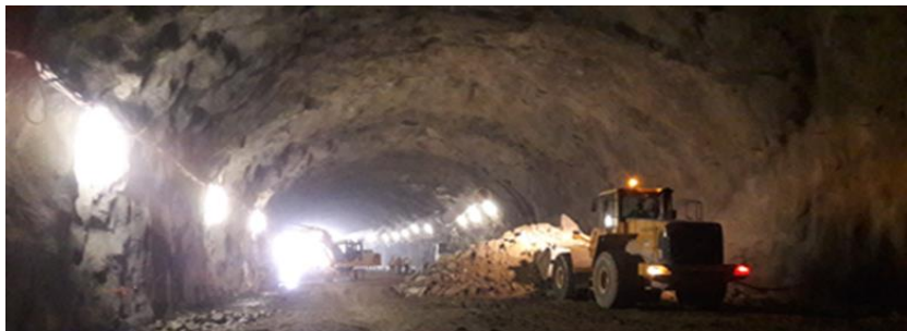
Figura 10 - Atividade de remoção de escombro (Fonte: Consórcio)
