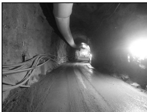
Figura 5- Soleira regularizada com produtos resultantes da escavação.
