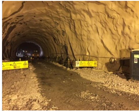
Figura 7 - Sinalização de rebaixos em frentes de escavação (fonte: autores)
