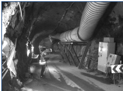
Figura 18- Manga de ventilação flexível e insuflável, ventilador com silenciador.
