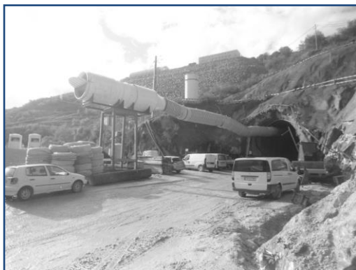
Figura 14- Localização do ventilador no exterior com manga de condução
