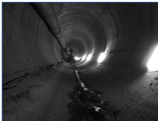
Figura 11- Luminárias colocadas verticalmente ao longo dos hasteais
