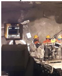
Figura 93 – Execução de Swellex (Fonte: Consórcio)
