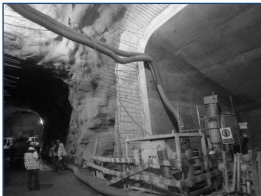
Figura 15- Sistema de extração de poeiras e de gases com manga de condução dos poluentes para o exterior.
