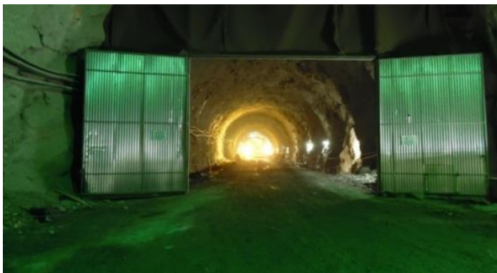
Figura 5 – Portão de delimitação de zona de revestimento definitivo (fonte: autores)
