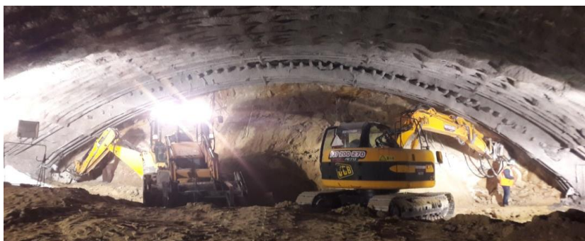
Figura 11 – Saneamento mecânico (Fonte: Consórcio)
