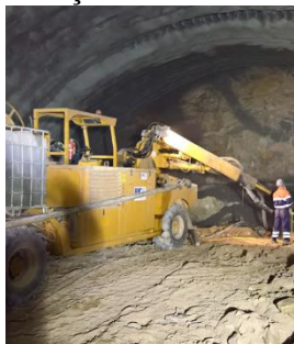
Figura 82 – Aplicação de betão projetado (Fonte: Consórcio)
