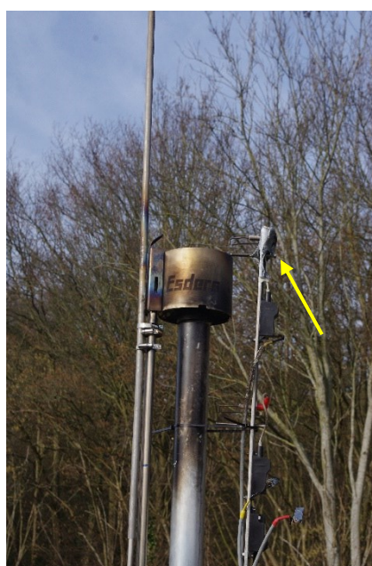
Figuur 3 De brander van de fakkel met de aanzuigleiding van rookgassen (rode pijl) en Figuur 4 en Figuur 5 De brander van de fakkel met de toegevoegde vonkontsteker (gele pijl).
