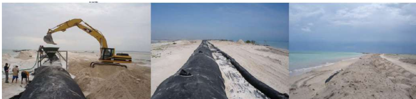
Figura 12. Construcción de una duna artificial con tubo geotextil en Las Coloradas, Yucatán. Fuente: AXISIMA (2017).
