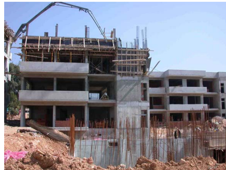
Εικόνα 10.2: Σκυροδέτηση πλάκας σε εργοτάξιο.
