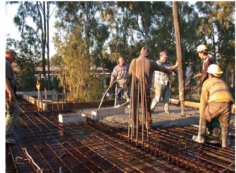
Εικόνα 10.5: Σκυροδέτηση πλάκας.
