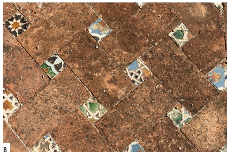
FIG. 6 – Sala do Capítulo, onde são visíveis azulejos – policromos, em corda seca e aresta – integrados no pavimento, no frontal do altar e num banco, bem como vestígios de assentamento na parede (A); pormenor do pavimento (B).
