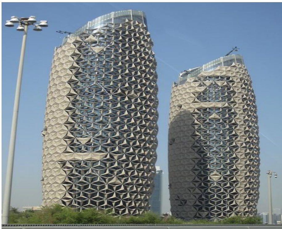
1-rasm. Al-Bahr minoralari (Abu-Dabi, BAA) – quyoshga mos ravishda avtomatik ochilib-yopiluvchi panjaralar.
