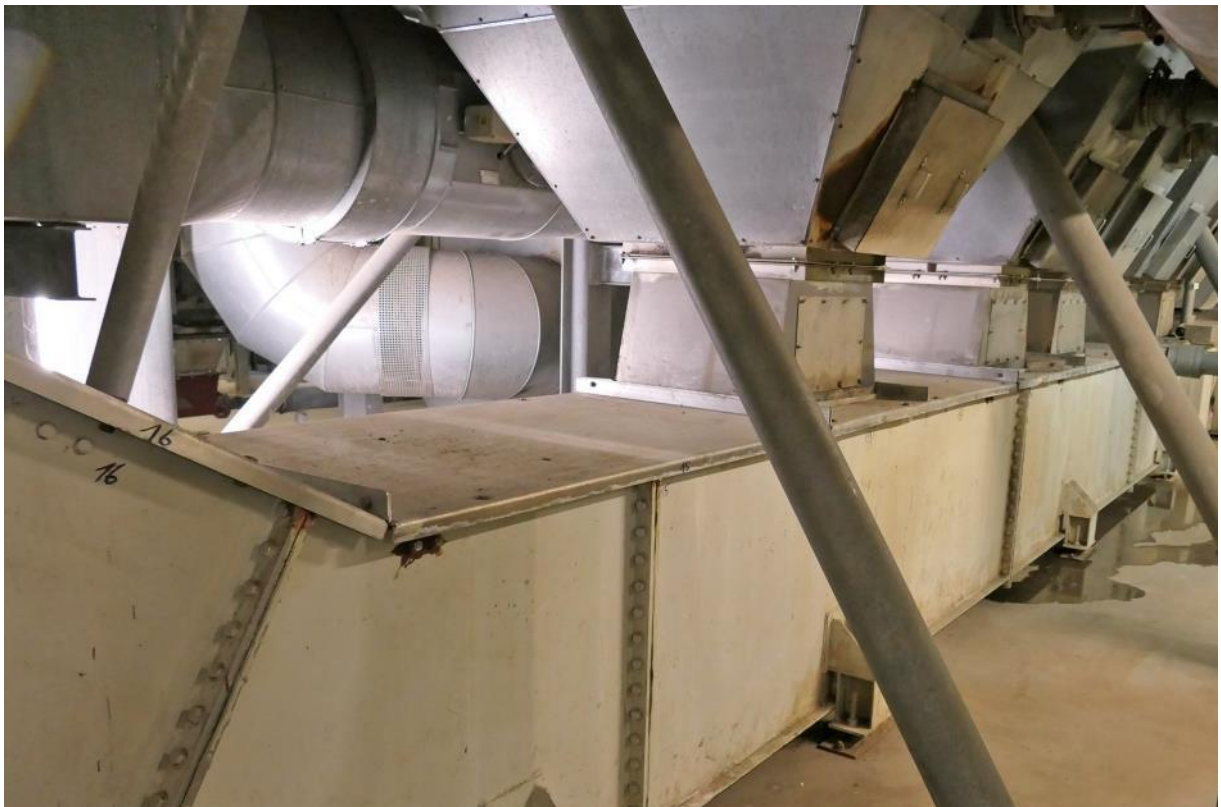
Abbildung 32: Die Rost- und Kesselasche fällt in diese wassergefüllte Wanne unter dem Heizkessel und wird über einen robusten Trogkettenförderer durch die Gebäudeaußenwand zum Aschebunker gefördert.
