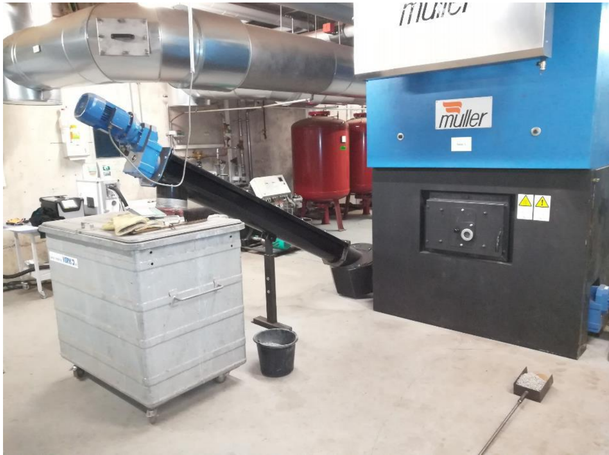
Abbildung 43: Heizkessel mit Rostascheaustrag per Schneckenförderer in einen Roll-container, der zum Entleeren aus dem Keller vor das Gebäude transportiert werden muss und dort mithilfe eines Laders in einen Container geleert wird
