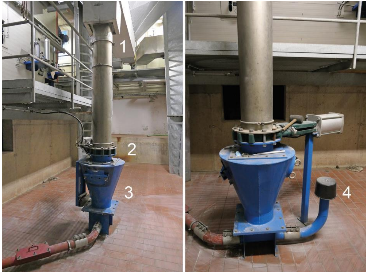
Abbildung 35: Übergabe der E-Filterasche über eine Zellradschleuse (1) und einen Schieber (2) an einen Trichter (3), der die Filterasche dem erzeugten Luftstrom beimischt. Direkt hinter dem Trichter befindet sich der Ansaugstutzen für die Förderluft (4).
