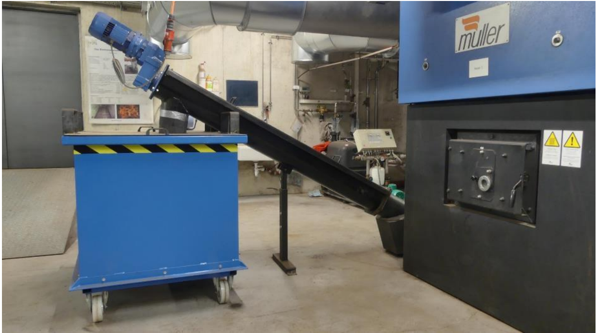
Abbildung 44: Neu beschaffte Klappbodenbehälter mit Einfahrtaschen für Staplergabeln machen das Entleeren der Aschebehälter in einen größeren Aschcontainer nun einfacher. Sobald der Behälter mittels Stapler positioniert ist, lässt sich der Boden öffnen und die Asche fällt in den Sammelcontainer.
