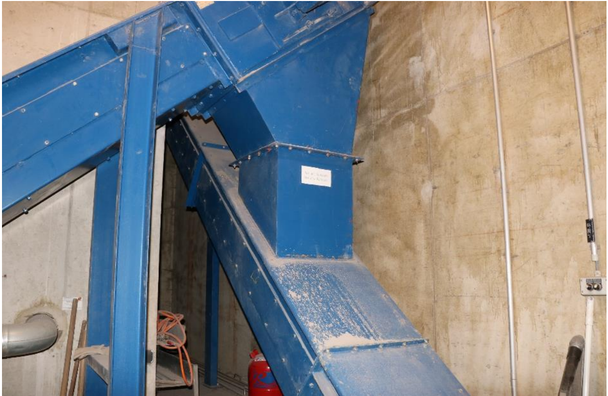
Abbildung 18: Für die Qualitätssicherung von Aschen ist die Kenntnis der Förderwege der Asche relevant. Hier: Übergabe der Rostasche an den Trogkettenförderer, der die Rostaschen durch die Gebäudeaußenwand in den davor aufgestellten Container fördert
