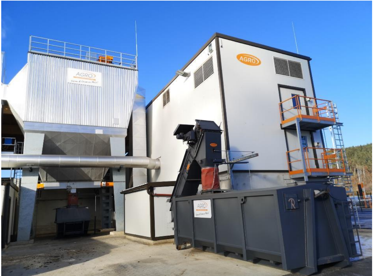
Abbildung 42: Abrollbehälter für die Rost- und Kesselasche, die mittels Trogkettenförderer aus dem Heizhaus transportiert wird. Dieses System bietet sich für trockene Aschen an, da der geschlossene Container Staubbelastungen bei Befüllen und Transport verhindert.
