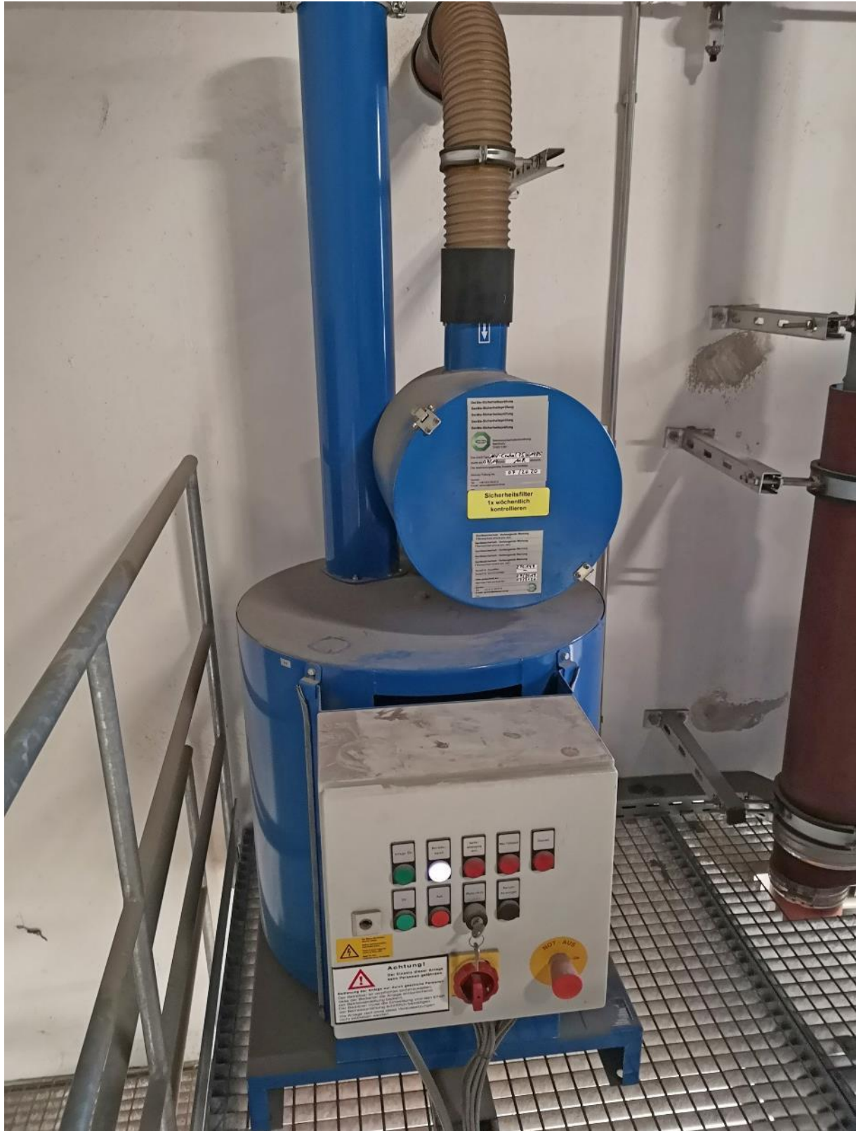
Abbildung 37: Das notwendige Vakuum für die stationäre Absauganlage wird mit diesem Saugaggregat erzeugt. Laut Herstellerangabe wird der Unterdruck durch eine oder mehrere Seitenkanal-Vakuumpumpen erzeugt.
