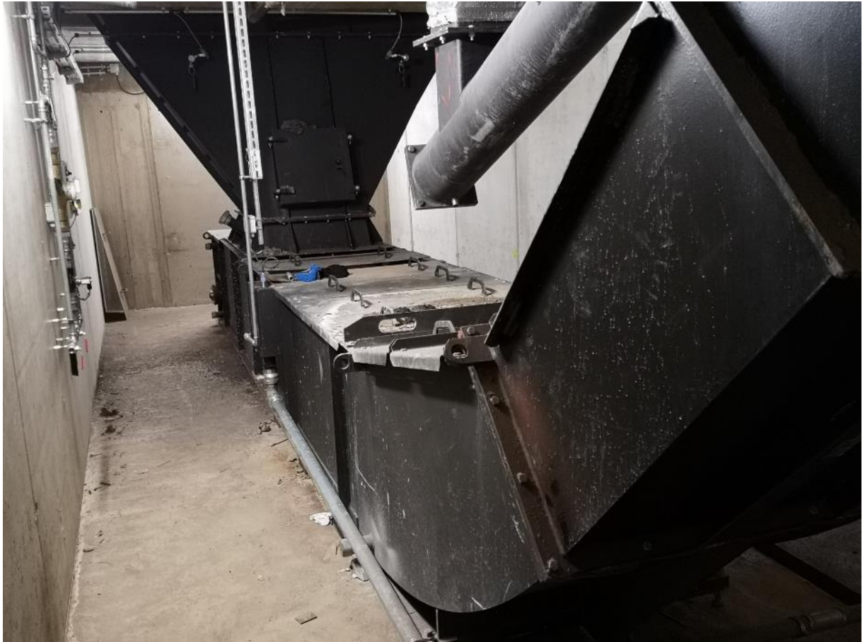
Abbildung 40: Über einen Trichter fällt die trockene Rost- und Kesselasche in ein Wasserbad. Mittels Trogkettenförderer wird die Asche dann in den Aschebunker transportiert.
