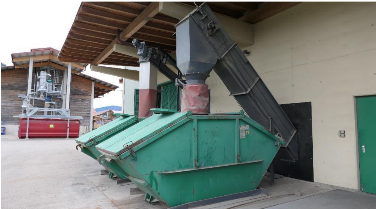
Abbildung 26: Lagerbehälter für die E-Filterasche (Hintergrund) und die Rost- und Kesselasche. Die Aufstellung der Container zur Aschelagerung vor dem Gebäude trägt zu einer geringeren Staubbelastung im Heizhaus bei und erleichtert das Auswechseln der Behälter.
