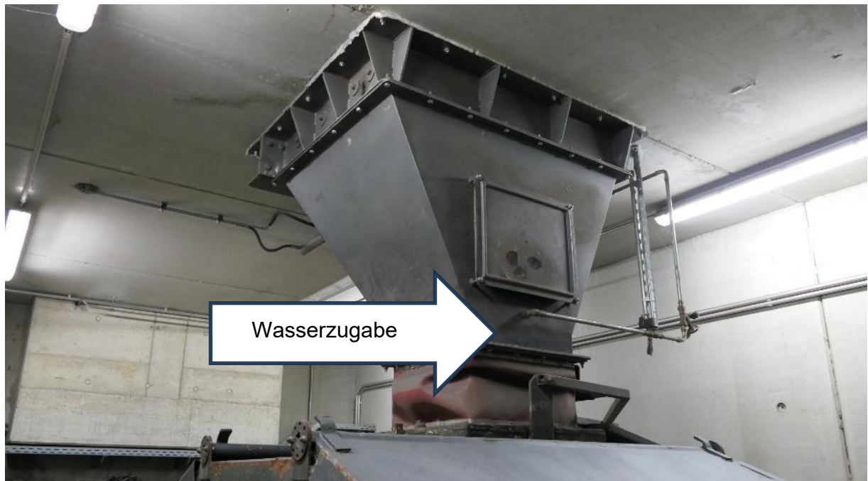
Abbildung 29: Oberhalb dieses Trichters befindet sich ein waagrechter Schieber. Wenn dieser geöffnet wird, fällt Asche in den Container. Die Leitung an der Verengungsstelle des Trichters dient der Wasserzugabe während des Ascheaustrags.
