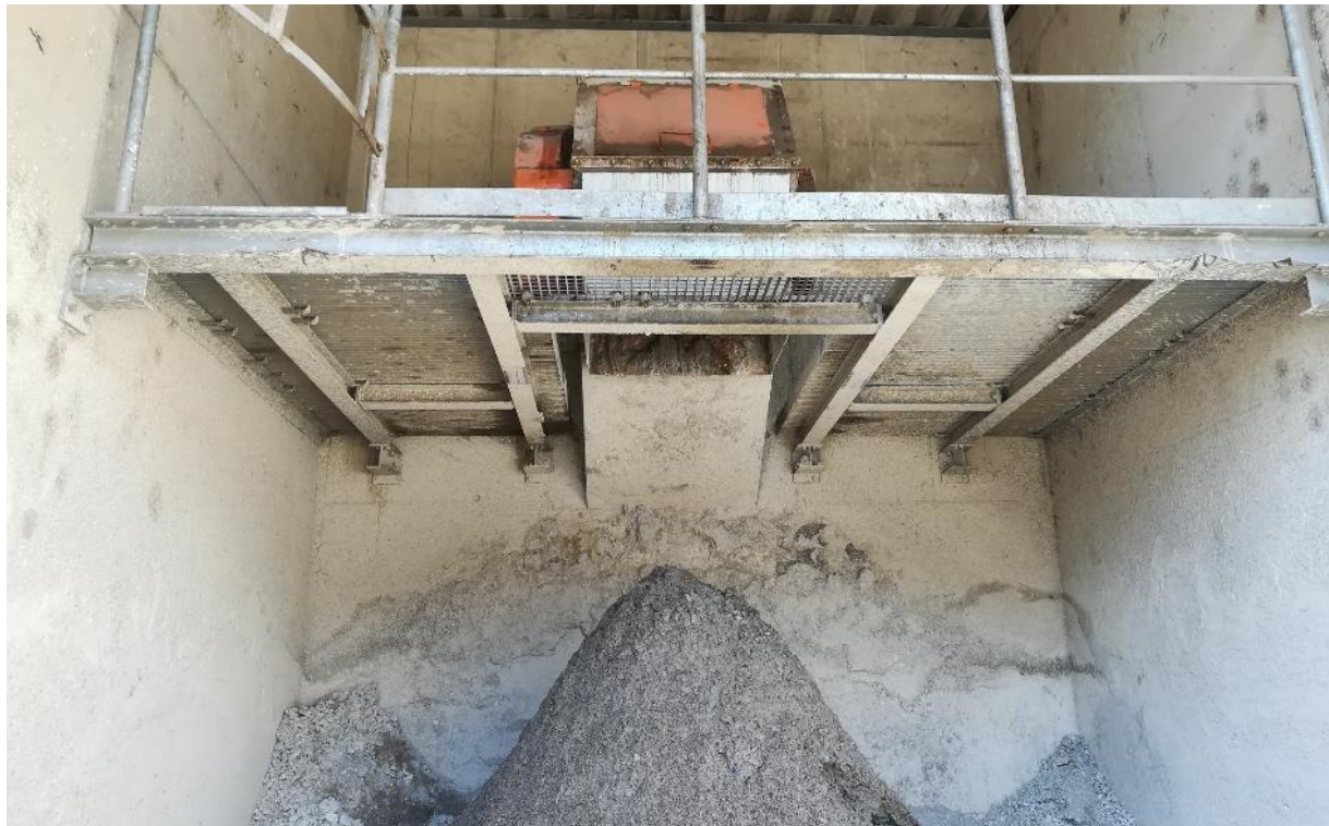
Abbildung 33: Ascheabwurf der nassen Asche in den Aschebunker vor dem Heizhaus
