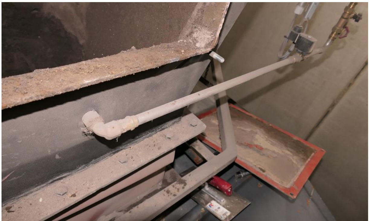
Abbildung 30: Detailaufnahme der Zuleitung für die Wasserzugabe. Im Vordergrund der Trichter, durch den die Asche in den Container fällt, im Hintergrund der Magnetschalter, der den Wasserhahn dann öffnet, wenn Asche in den Container fällt.
