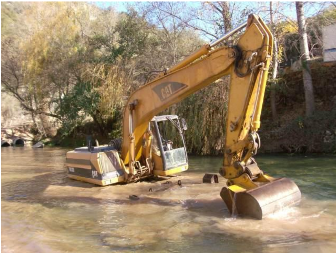
Limpeza do interior do rio frente à piscina e construção do talude (espelho de água - )
