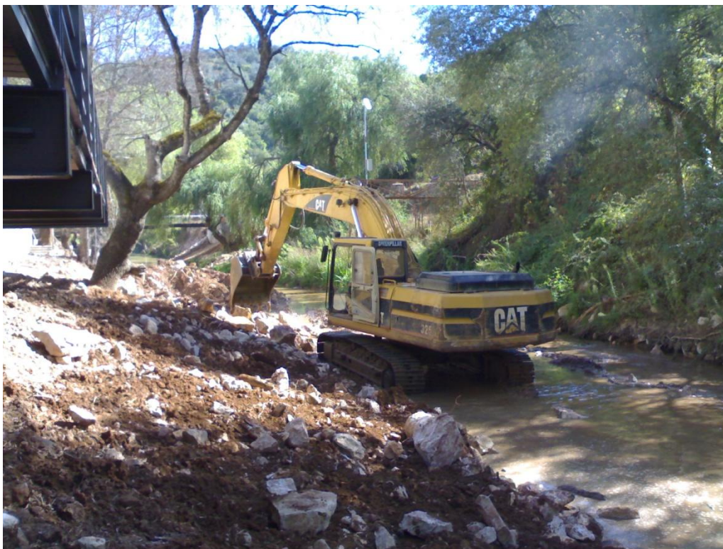
Limpeza das terras e construção do talude lateral (1ª fase trabalhos)
