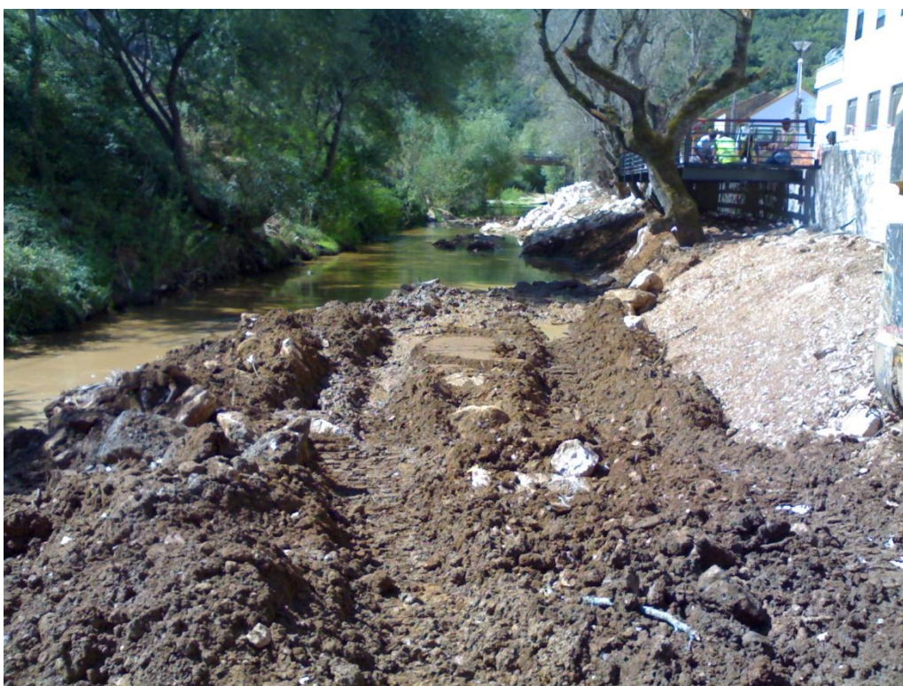
Zona de talude já construído e da zona de limpeza a efectuar (1ª fase trabalhos)
