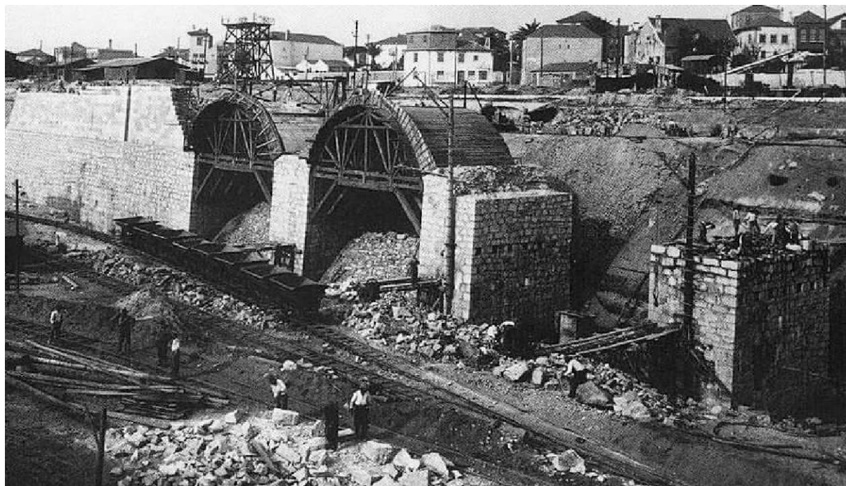
Fotografia do muro-cais em arcadas durante a sua construção
