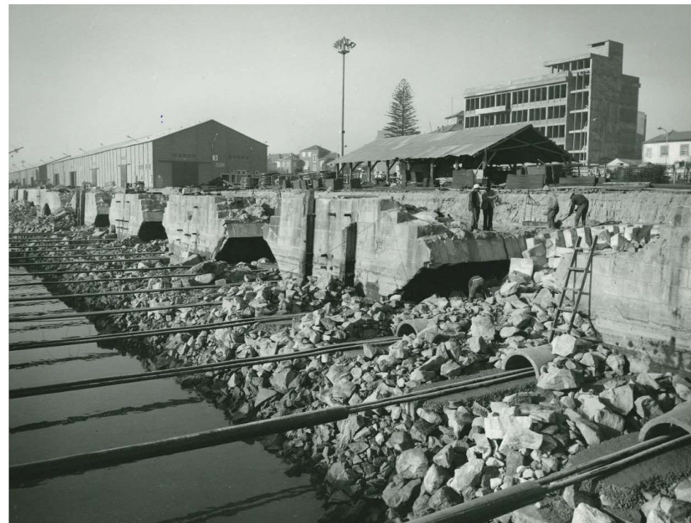
Demolição parcial das arcadas de granito para instalação dos tirantes de ancoragem
