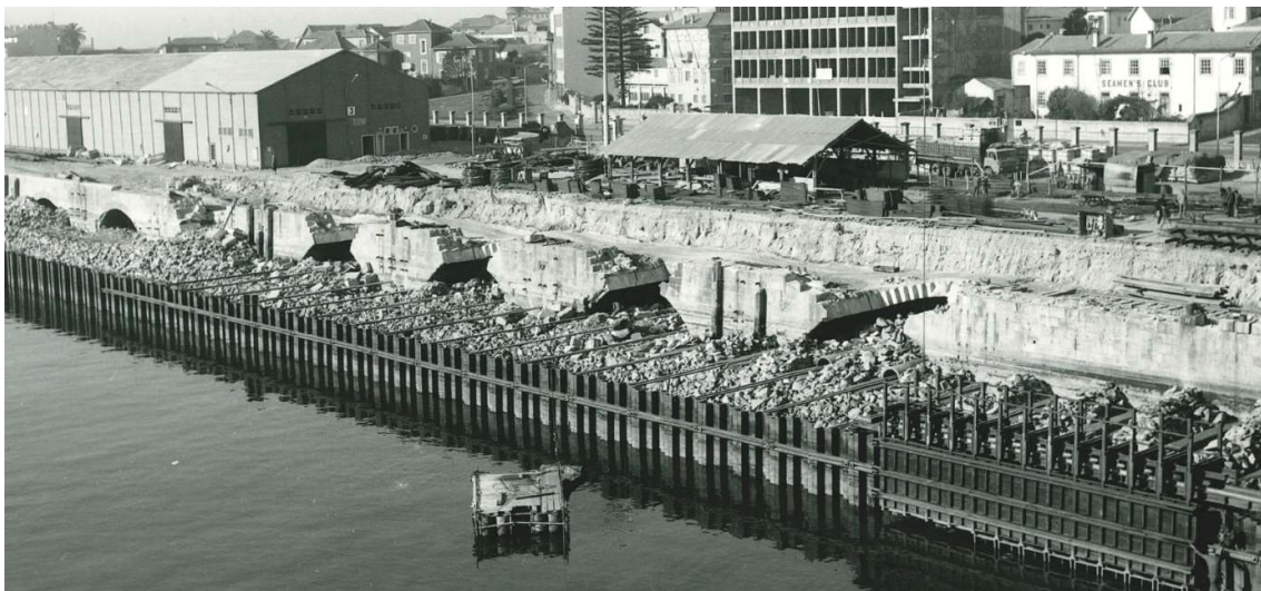
Vista da estrutura do cais avançado em estacas-pranchas durante a sua construção
