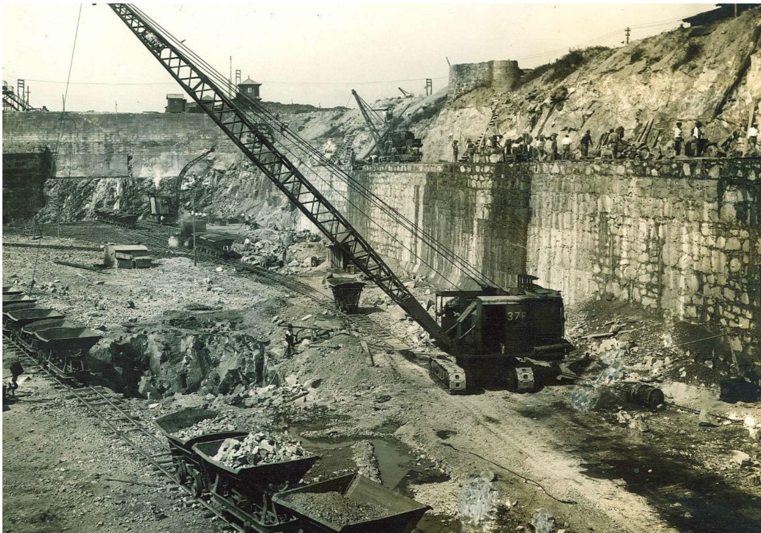
O cais foi construído a seco, na década de 1930
