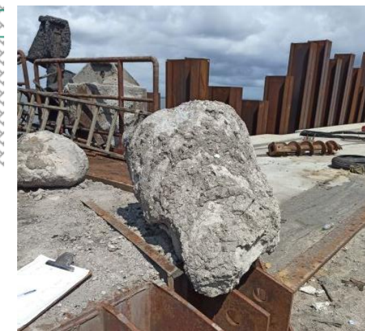
Pré-furação para limpeza de obstáculos
