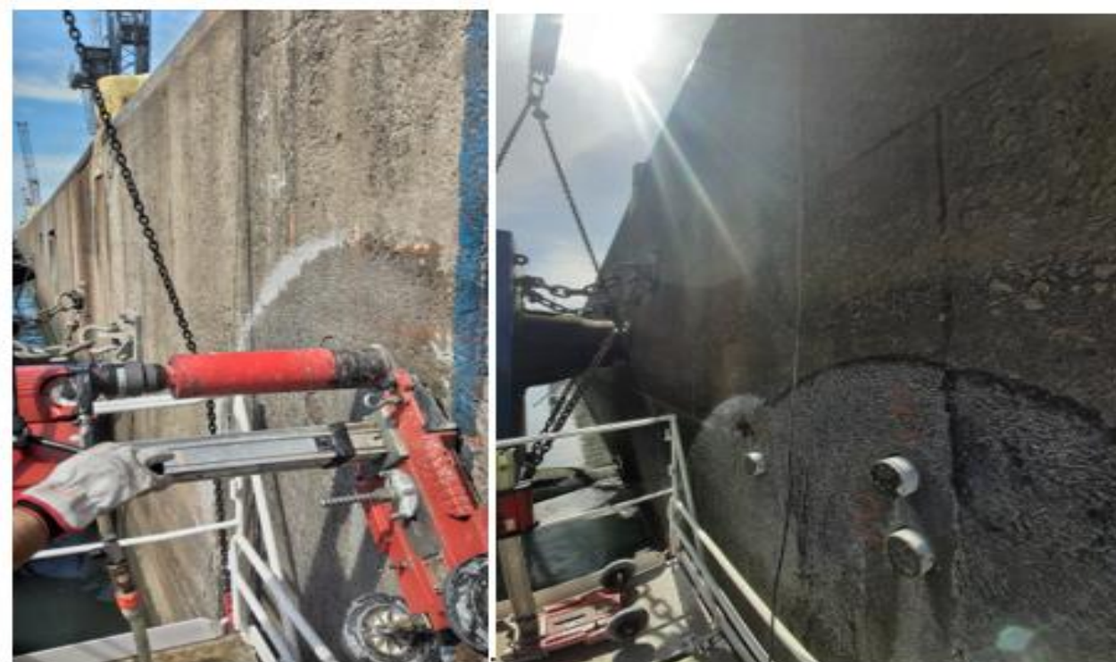
Extração de carotes, instrumentação em laboratório, reimplantação
