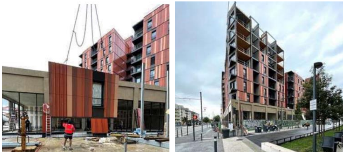
Ilustración 2: Cerramiento no portante en el edificio Wood' Art-La Canopée en Toulouse, Francia (Basterra et al. 2021)
